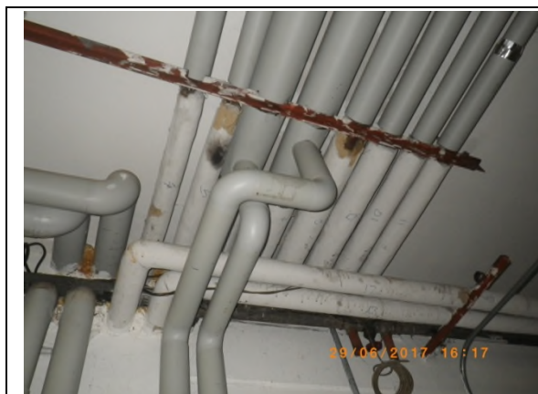
Rivestimento delle tubazioni nella centrale termica
