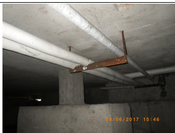
Rivestimento delle tubazioni nel vespaio
