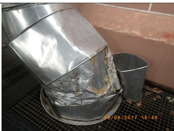
Camino con coibente in FAV all'esterno dell'edificio
